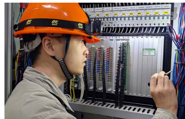
青山公司开展设备巡视，仔细排查设备隐患
